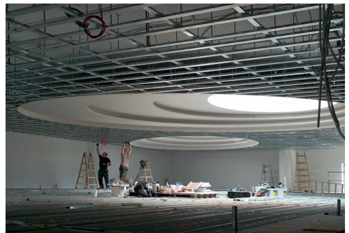
Детали: потолочная конструкция в Институте им. Макса Планка (Фото: Ruben Peter Ausbau GmbH)
