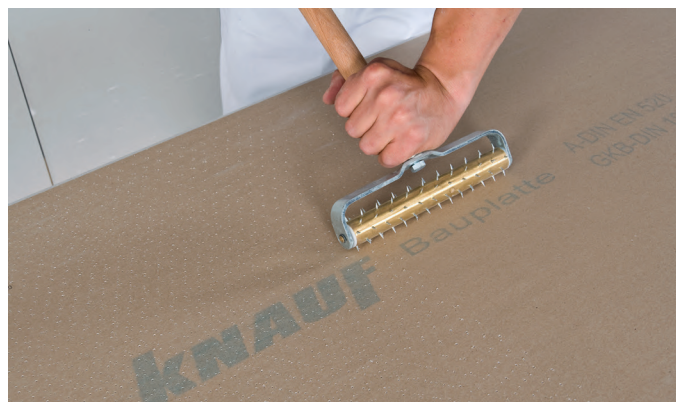
Рис. 2: Укладывание гипсокартонных КНАУФ-листов на шаблон
