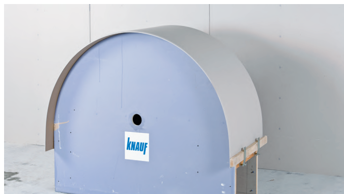
Рис. 4: Фиксация гипсокартонных КНАУФ-листов на шаблоне
