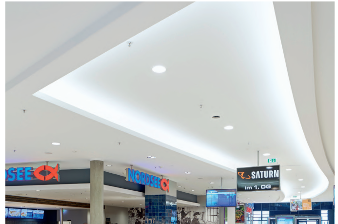
Заглубленные потолочные плоскости со светящимися вутами направляют посетителей и мастерски выделяют проходы между магазинами. Одних только Г-образных ранее заготовленных элементов было установлено 2500 погонных метров.
