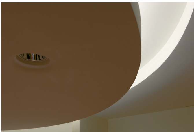
Совершенные скругления. Соорудить такую потолочную конструкцию стало возможным благодаря ранее заготовленным элементам.
