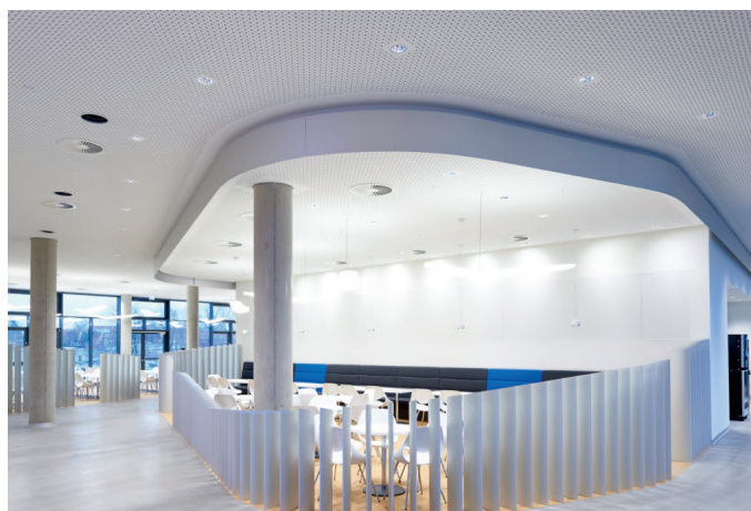
Скругленные ранее заготовленные элементы KNAUF также создают форму подвесного потолка зоны столовой в приемной зоне центра, обрамленной алюминиевыми стенами.
