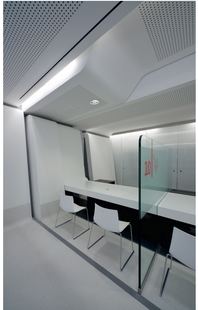
Обшивка потолка акустическими плитами KNAUF-Акустика (Фото: Knauf / Albert)
