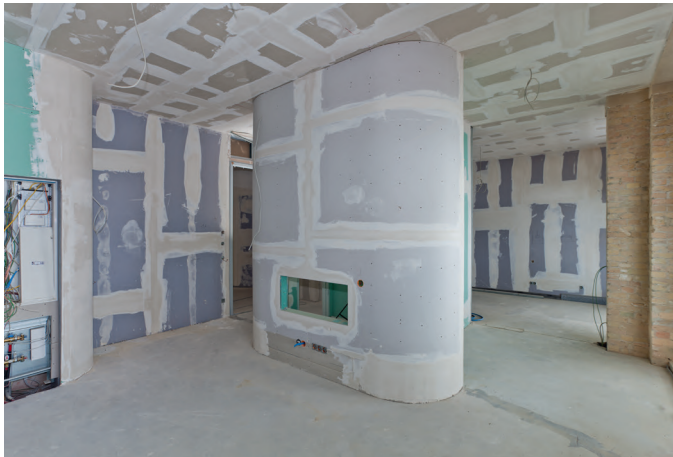
Ноу-хау в области сухого строительства КНАУФ образуют основу — и не только в области интерьерных решений с изогнутыми элементами
