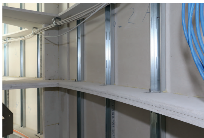
С точностью до миллиметра: место соединения двух модулей рядом друг с другом и двух модулей друг над другом
