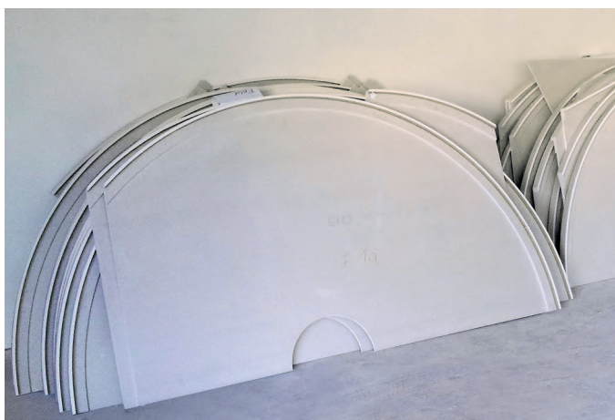
Предварительно смонтированный комплект для установки полностью готовых сегментов парящих потолков (Фото: Jaeger Ausbau)
