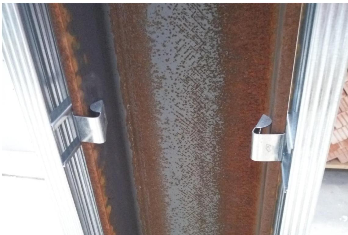
Рисунок 4. КНАУФ-профиль ПП 60/27 установленный на металлическую колонну с помощью зажимов 70x48x42
