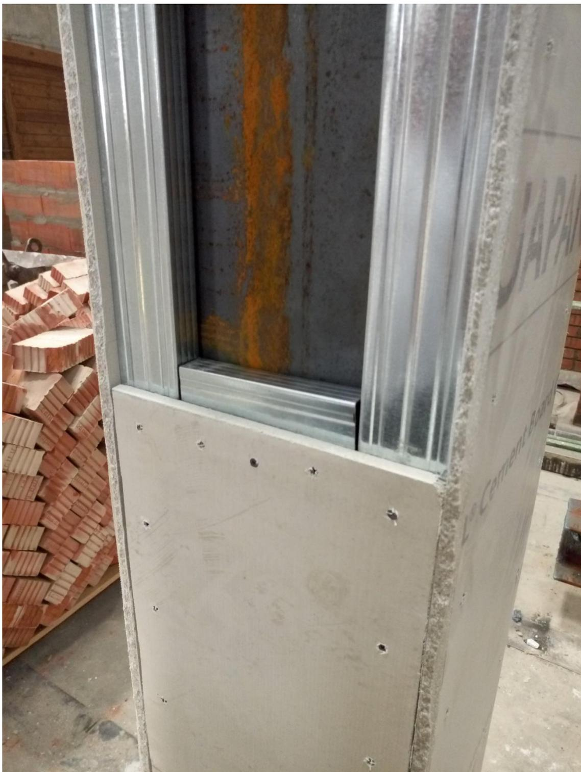
Рисунок 6. Вставка из КНАУФ-профиля ПП 60/27 в месте устройства горизонтального стыка при монтаже облицовки колонны, выполняемой с использованием цементно-минеральных плит АКВАПАНЕЛЬ® Наружная
